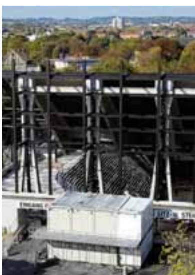
Vor Baubeginn konnte man durch die Grünanlagen hinter dem Eisstadion zum Alten Einlass gelangen, das geht seit Baubeginn nicht mehr. Foto: Anne Wall
